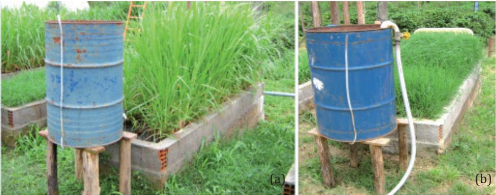
**Figura 12.** Sistemas Alagados Construídos, em escala experimental, cultivados com capim elefante (a) e Tifton 85 (b), utilizados no tratamento de água residuária de laticínios.
