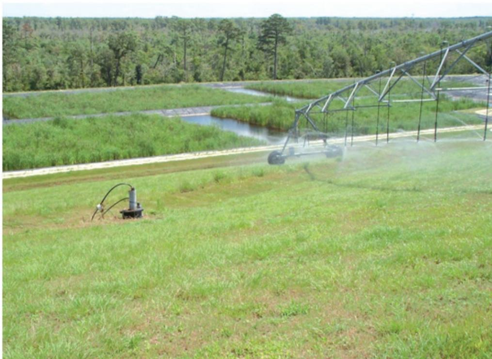
**Figura 2.** Reúso de efluentes de Estação de Tratamento de Esgotos em sistemas integrados de irrigação e *wetland* construído – Nova Hanover, Carolina do Norte - EUA.
