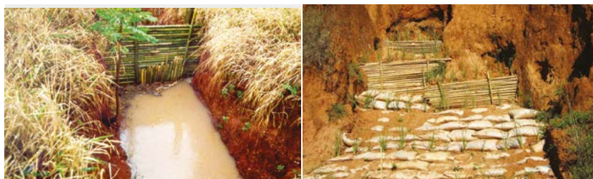
Figuras 6.81 e 6.82 – Paliçada de bambu em voçorocas retendo a enxurrada (esq.) e de saco de terra associado com bambu em início de revegetação (dir.).
