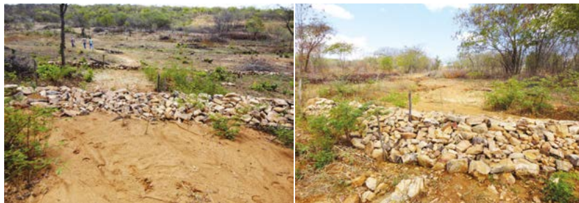
Figuras 6.118 e 6.119 — Detalhes da retenção de sedimentos por um barramento assoreador, em um local de concentração de enxurrada no Rio Grande do Norte.
