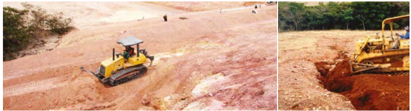
Figuras 6.69 e 6.70 – Detalhes da sistematização do terreno eliminando os sulcos no solo.
