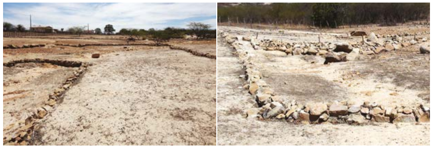
Figuras 6.116 e 6.117 – Imagens do barramento com pedras distribuídas em nível no terreno (esq.) e detalhe dos sedimentos retidos junto ao renque de pedras (dir.).
