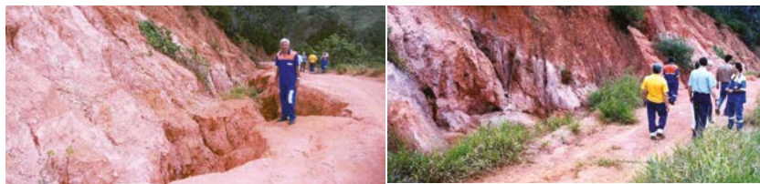
Figuras 6.88 e 6.89 — Detalhes da erosão em estrada rural ocasionada pela drenagem superficial deficiente.
