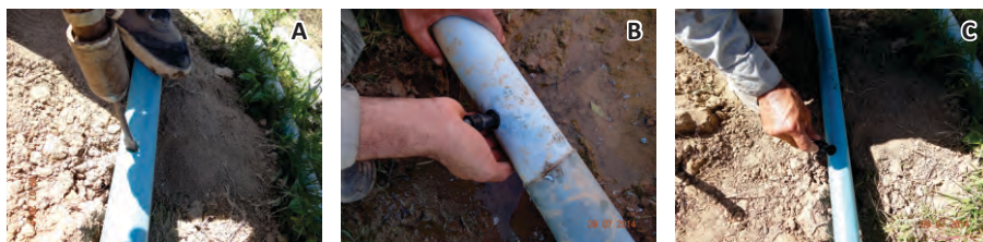
Figura 28. Furar o tubo de PVC com broca (A) para inserir no furo a chula (B) e em seguida inserir a saída de linha lateral (C).
