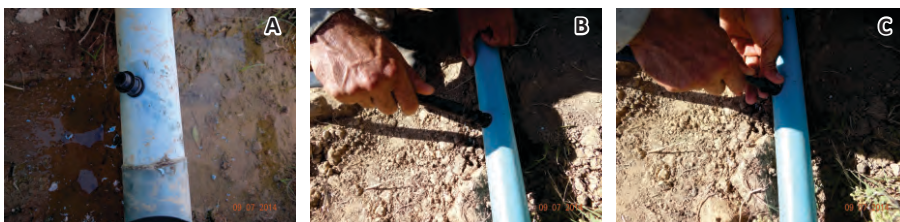
Figura 29. Furar o tubo de PVC com broca (A) para inserir no furo a chula (B) e em seguida inserir a saída de linha lateral (C).
