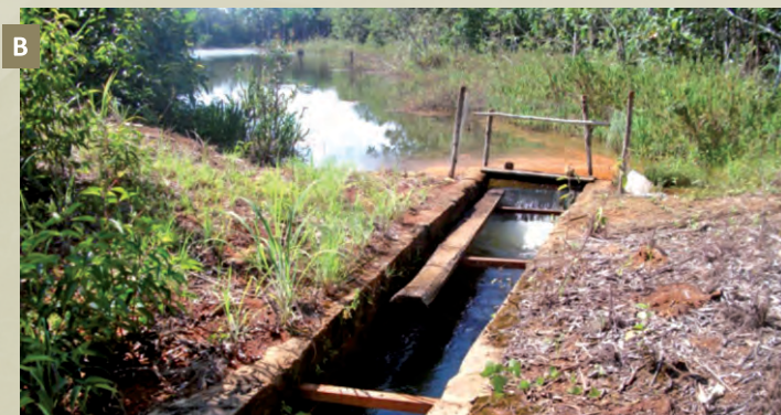
Figura 4. Vertedouros de barragem: (A) maior porte, (B) menor porte, ambas com tela para contenção dos peixes no cultivo em caso de verter água.
