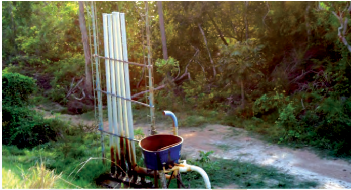
Figura 3. Sistema de drenagem de água do fundo de barragem de cultivo por meio de canos.
