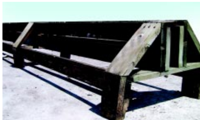
Túnel de ventilação (Vista Lateral).
