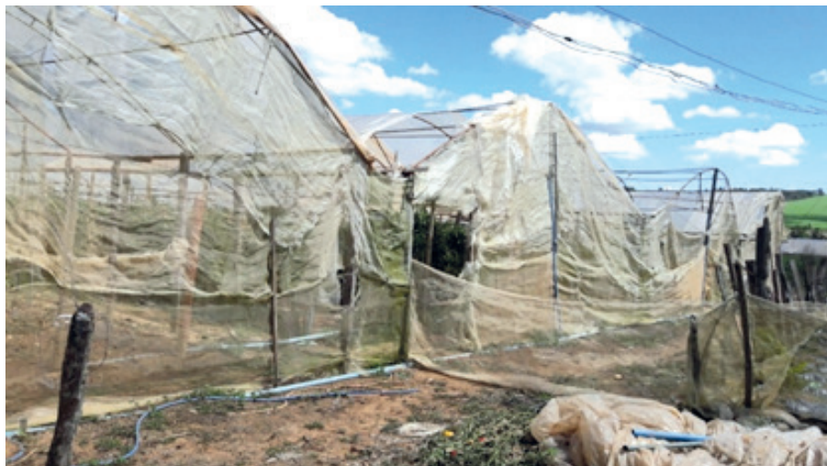
Figura 10. Estufas em estado ruim de conservação.
