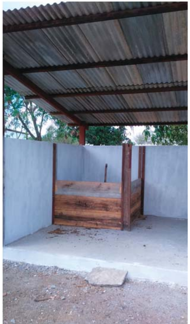
Figura 11. Composteira de carcaças com piso cimentado e paredes de tijolos.
