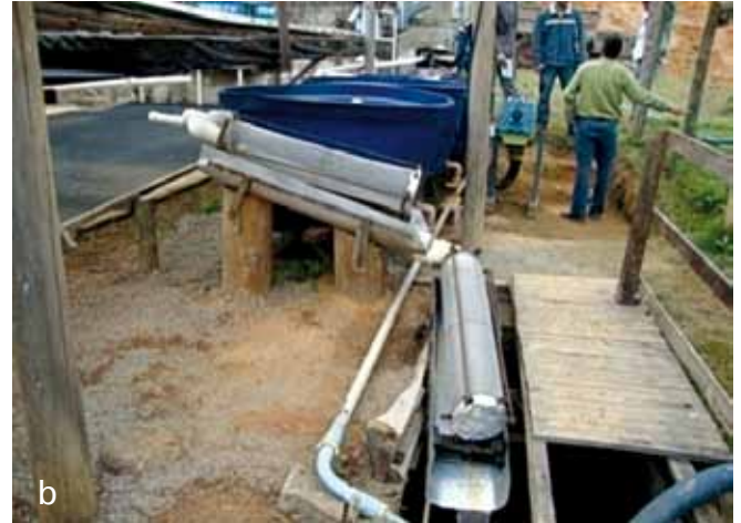
Figura 19. Bombeamento da caixa de decantação para reúso Sistema de limpeza de águas residuárias: caixas de decantação (a) e peneiras de retenção (b).
