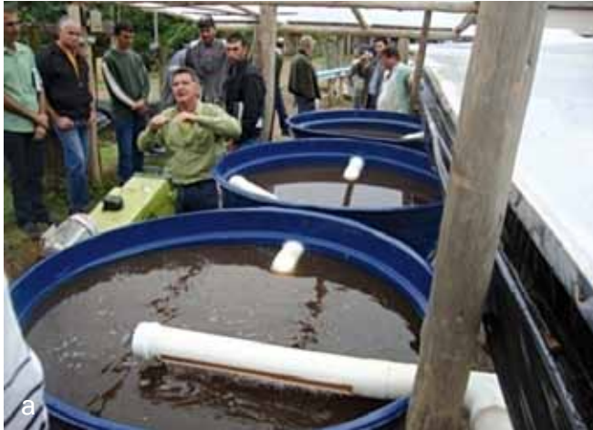
Figura 19. Bombeamento da caixa de decantação para reúso Sistema de limpeza de águas residuárias: caixas de decantação (a) e peneiras de retenção (b).
