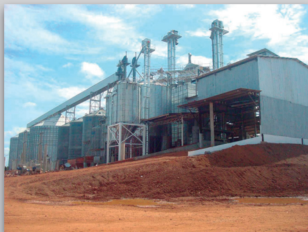
Figura 9. Construção de estrutura de secagem e armazenagem no Município da Lagoa da Confusão em janeiro/2013.
