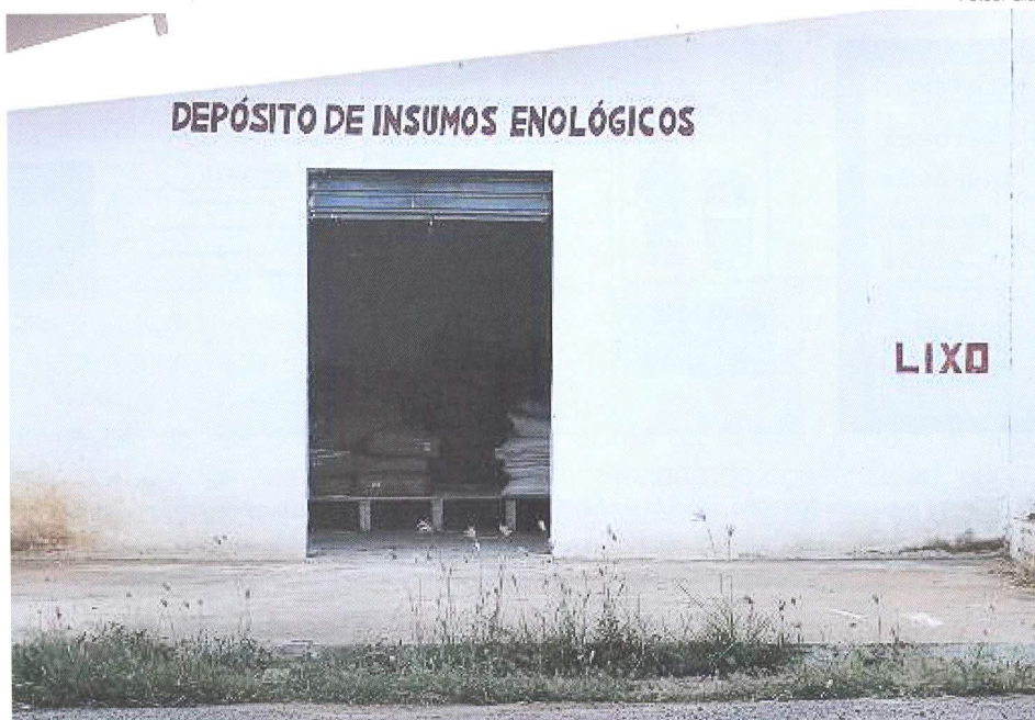
Figura 12: Esta figura exemplifica o depósito para armazenagem dos insumos enológicos fechado e isolado da vinícola, nota-se que os insumos encontram-se em pallets distantes do chão a uma altura de mais de 45 centímetros conforme indicado pelas regras de Boas Práticas de Fabricação.
