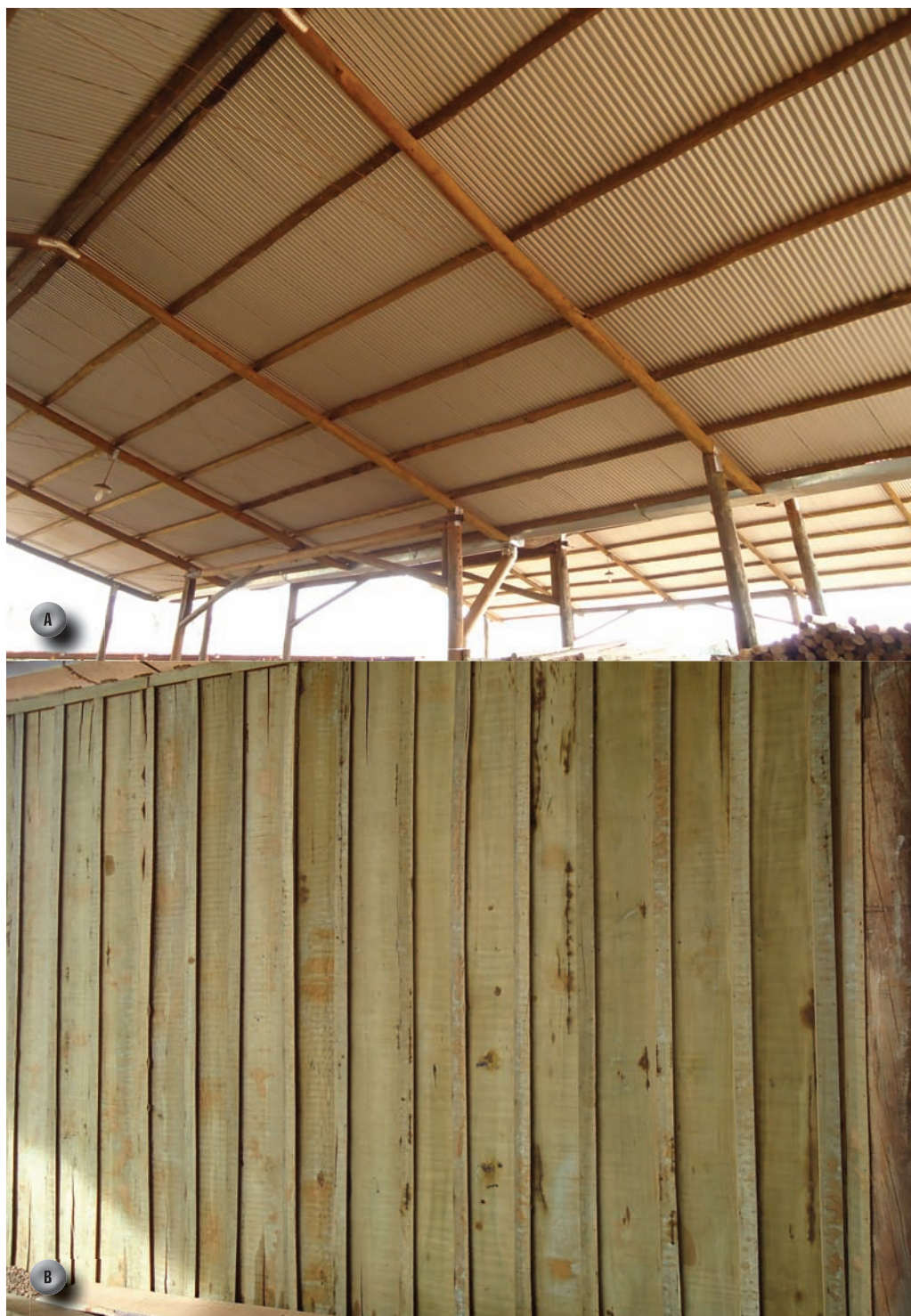
FIGURAS 9.14 A e B - Estrutura de galpão (A) e parede (B) feitas com madeira de eucalipto. Fotos: Davi José Bungenstab.
