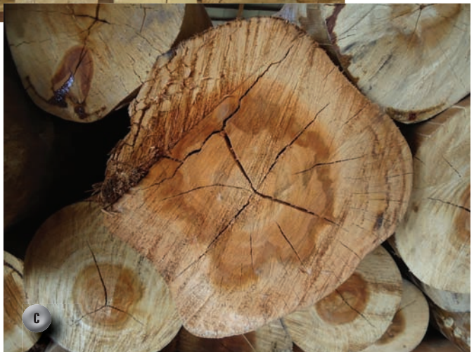
FIGURAS 9.15 A, B e C - Rachaduras em tábuas e toras de eucalipto provocadas pela tensão de crescimento e/ou processo de secagem inadequado. Fotos: André Dominghetti Ferreira e Davi J Bungenstab
