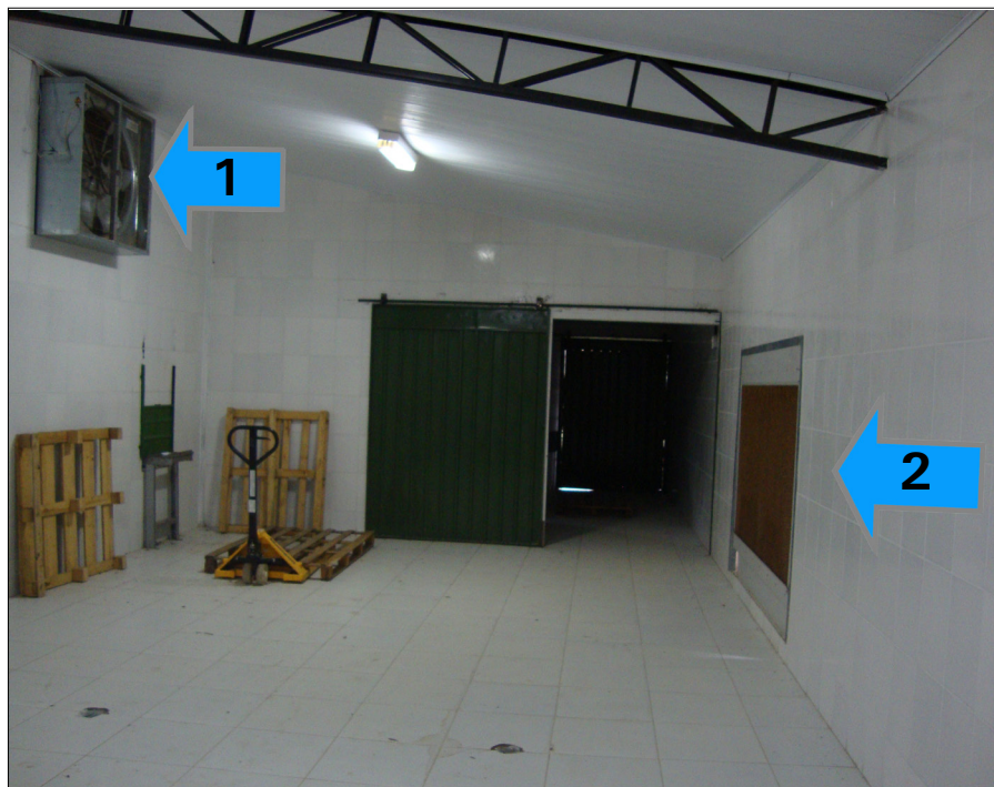
Figura 6. Sistema de umidificação do ambiente usado em Casa de Embalagem de uva, Petrolina-PE. O ar é puxado por um exaustor (1) através da argila expandida umedecida (2), de modo a elevar a umidade relativa do ambiente.
