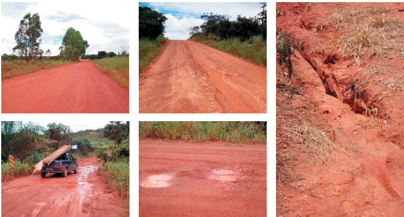
Fig. 7. Estradas distritais e vicinais do Núcleo Rural de Taquara cujas condições são variáveis em função da época do ano (chuva e seca) e da manutenção.
