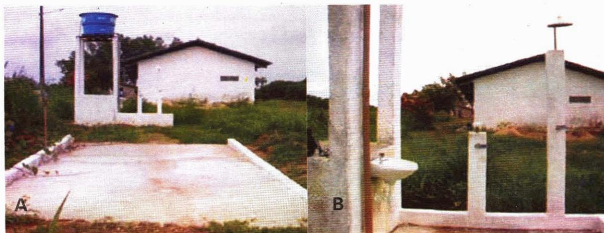
Fig. 2. Vista geral do ponto de mistura de agrotóxicos construído no setor de fruticultura (A), com detalhes do lava-olhos e chuveiro de emergência (B), no campo experimental da Embrapa Meio-Norte, em Teresina, PI.
