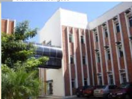
▲ Vista parcial do prédio II.
