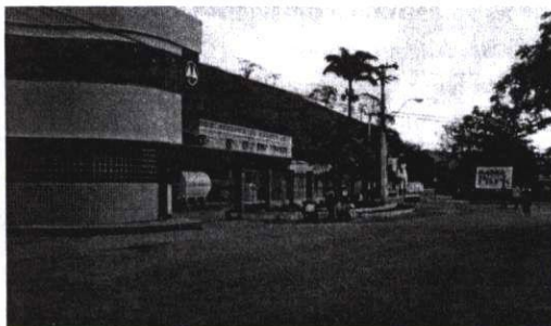
Fig. 4. Foto atual da Cooperativa de Macuco.
