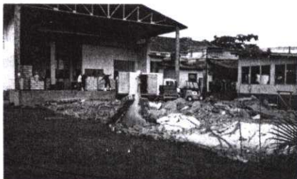
Fig. 3. Obras para a modernização da Cooperativa.
