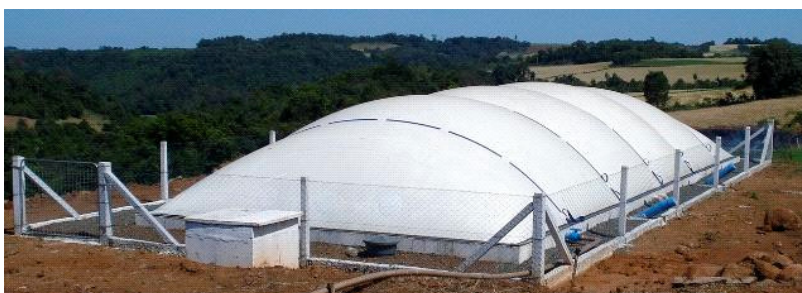
Fig. 1. Modelo de biodigestor em uso na produção de suínos.
