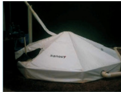
Fig. 3. Cisterna de vinimanta de PVC.
