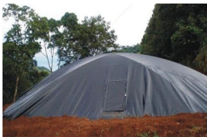
Fig. 4. Cisterna de manta de PEAD.
