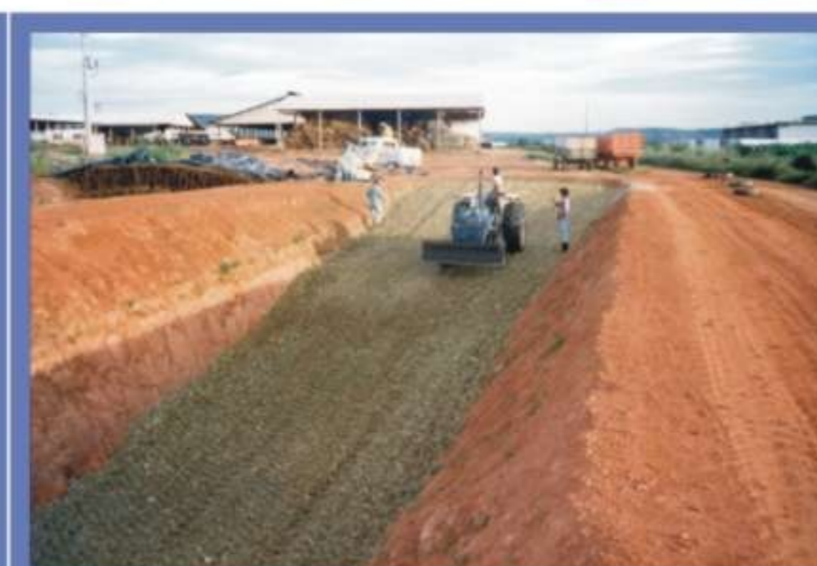
FIG. 3. Operação de enchimento do silo
