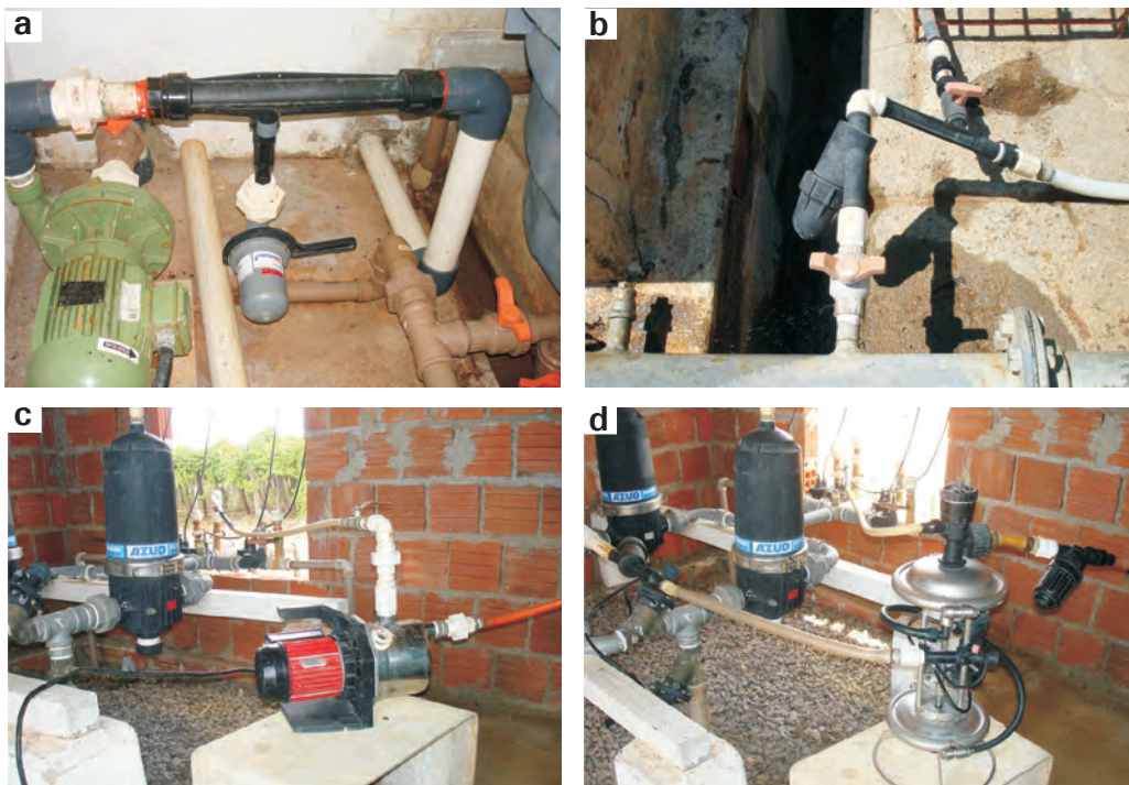
Figura 22. Cabeçal de controle com injetor de fertilizantes: a) tipo Ventury acoplado a bomba booster; b) tipo Ventury recebendo pressão da adutora; c) tipo bomba centrífuga acoplada a motor elétrico; d) tipo hidráulico consumindo pressão do cabeçal.
