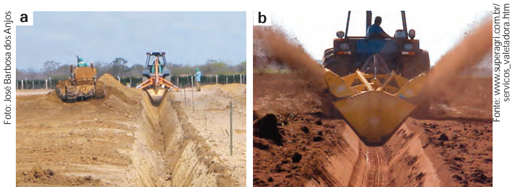
Figura 5. a) abertura de dreno com retroescavadeira; b) abertura de dreno com valetadora rotativa tracionada por trator.
