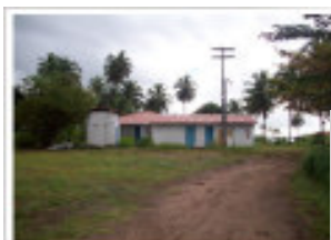
Prédio da Administração
