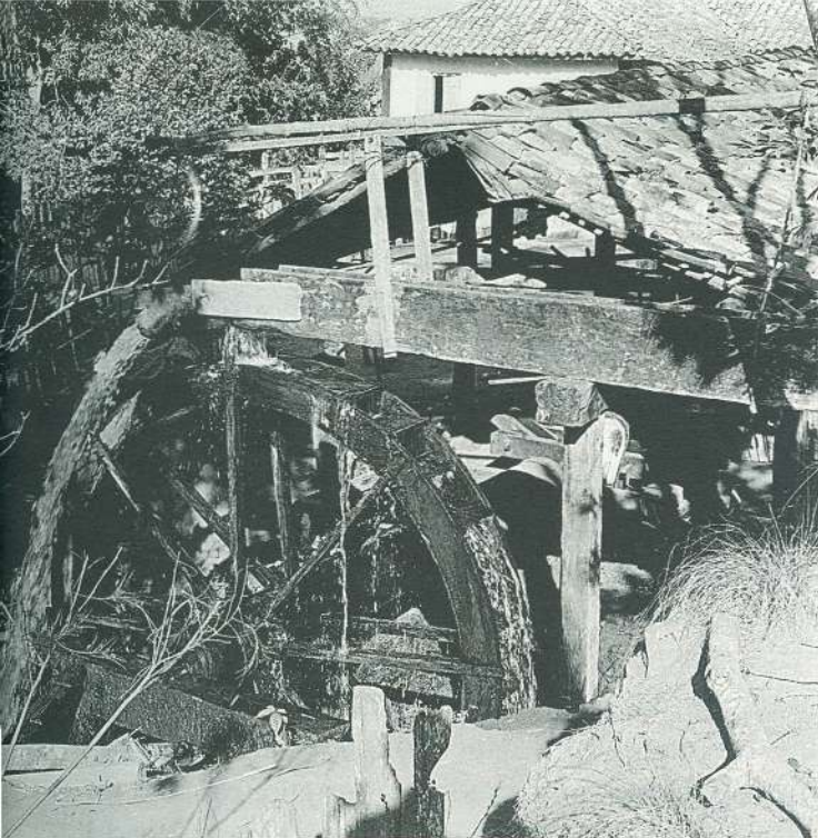
Roda d'água e pilhão - Sistema rústico de processamento de grãos - Fotos: Olímpio P. Oliveira Filho
