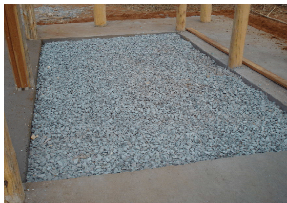
Figura 8. Camada de brita que isola o contato das espigas com o piso de chão batido e evita a formação de poça de água no fundo do paiol, caso ocorra uma forte chuva de vento.
