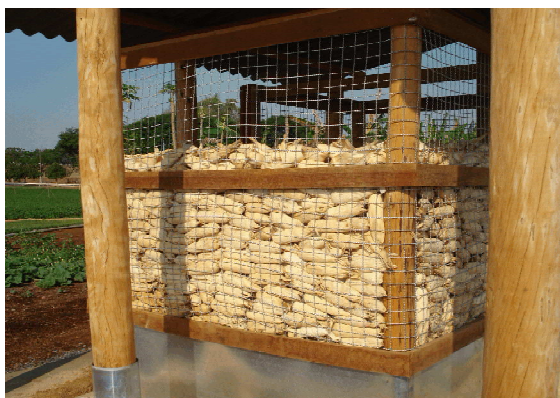
Figura 10. Ventilação natural pela parede de tela, que permite o milho completar a secagem depois de armazenado.
