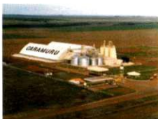
Unidade armazenadora em Chapadão do Céu-GO
