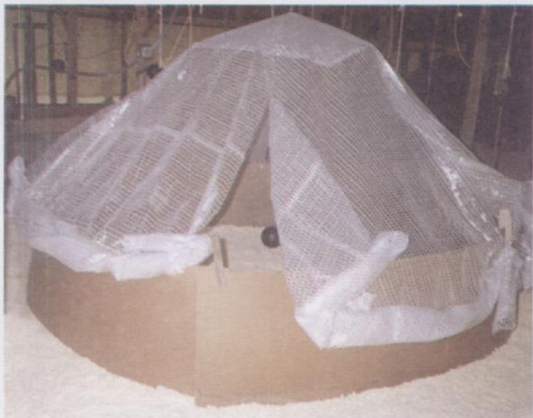
FOTO 4 - Vista frontal do círculo de proteção, dos sistemas de aquecimento em piso, com cobertura de lona plástica.
