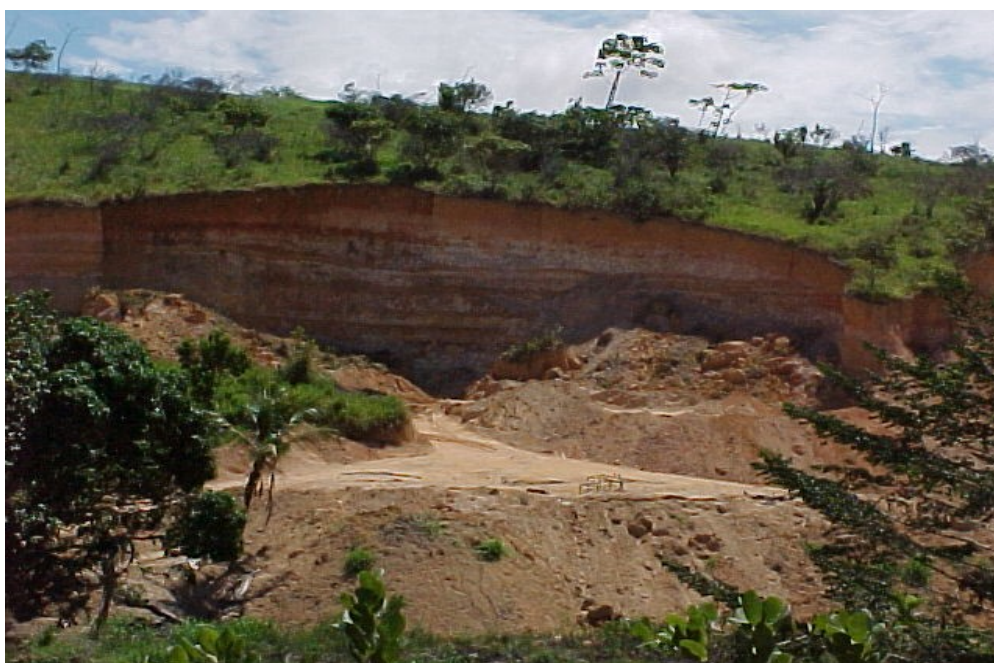
Figura 22. Encosta com relevo ondulado e forte ondulado servindo de áreas de empréstimo; são também áreas RA - RISCO ALTO para construção.
