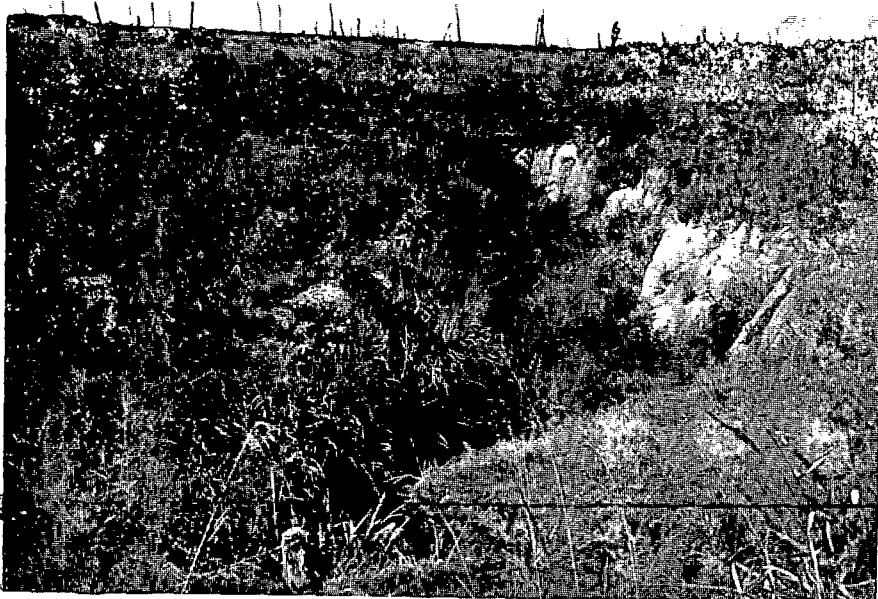
Fig. 11 — Aspecto do efeito da erosão na unidade PV 3
