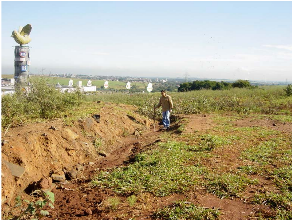
Fig. 6 – Detalhe da borda do terraço mal construída, direcionada à jusante da bacia, o que favorece um caminho preferencial das águas de escoamento superficial, causando ravinamento. Este erro, quase que pontual, gerou um risco de erosão na área, o que causou o rompimento dos camalhões dos terraços inferiores.
