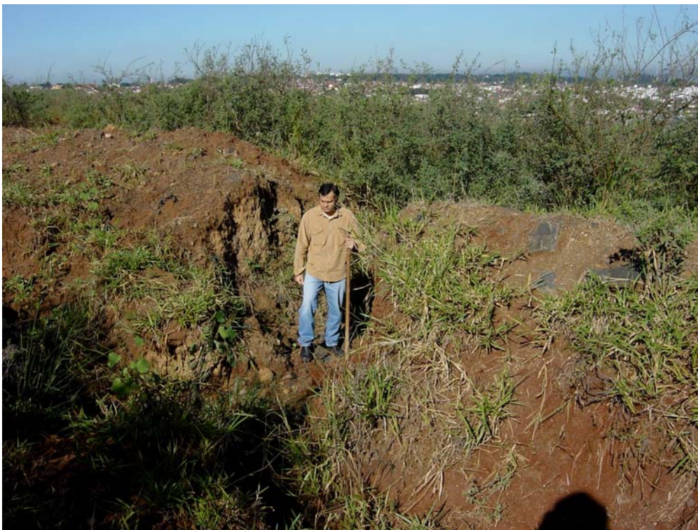
Fig. 7 – Detalhe de processo erosivo e do terraço rompido por má construção de outro terraço a montante, com necessidade de reparação.
