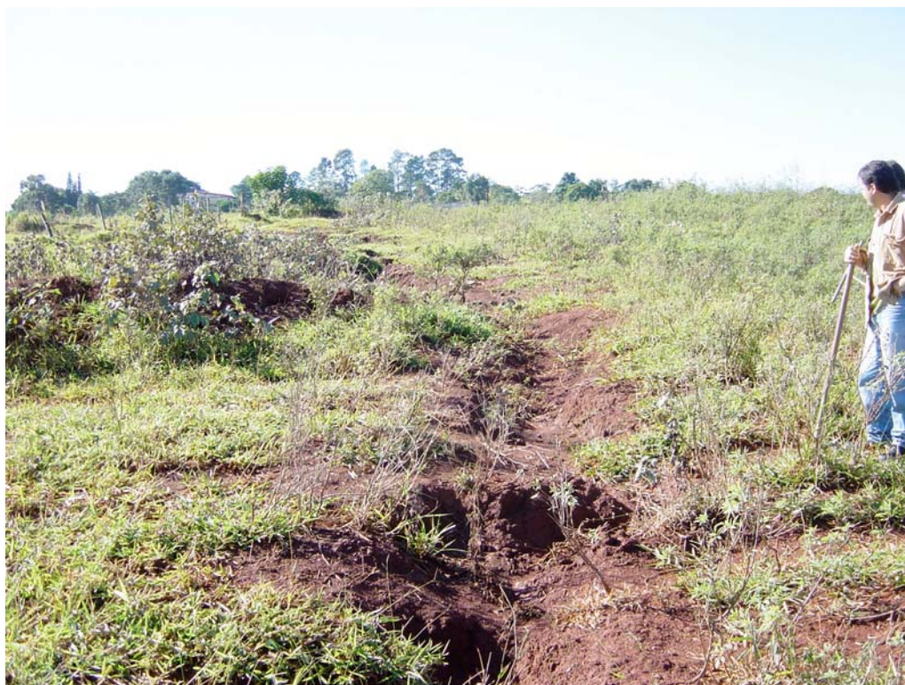
Fig. 10 – Detalhe de erosão por ravinamento gerada por ausência de terraço.
