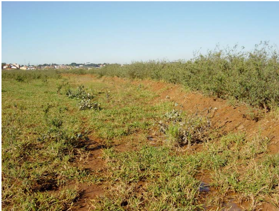
Fig. 5 – Detalhe de terraço construído na área nivelada do bota-fora do Parque Dom Pedro Shopping S/A (modelo ideal, tecnicamente bem executado).
