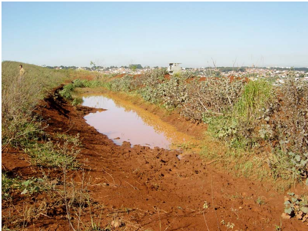
Fig. 9 – Detalhe da bacia de contenção evidenciando seu efeito positivo.
