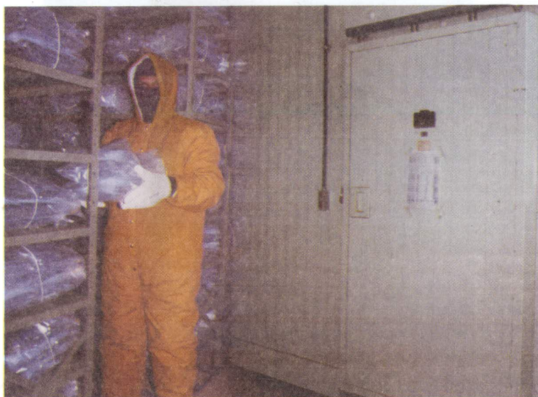
Fig. 5. Aspecto externo e interno de câmara fria.
