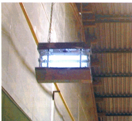
Fig. 9. Lâmpada ultravioleta para controle de insetos na casa de embalagem.
