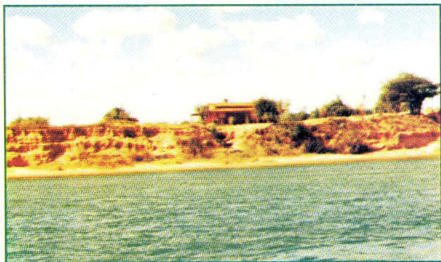
Expansão imobiliária - risco de desabamento.
