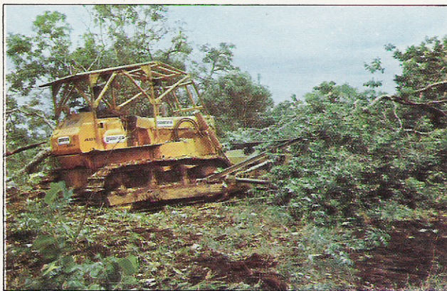
FIG. 1 – Desmatamento com trator de esteira.
