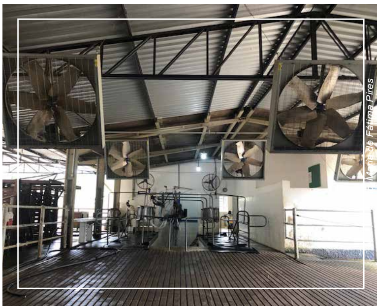
Figura 32. Ventiladores na sala de ordenha.
