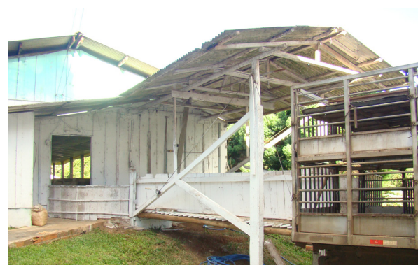
Figura 12. Embarcadouros com inclinações adequadas e rampas móveis.
