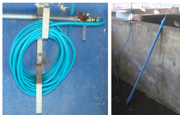
Figura 5. Sistema de ar comprimido utilizado para desembarque e condução dos suínos no frigorífico.
