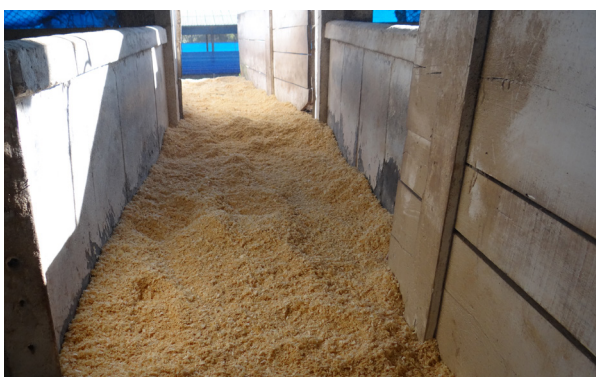
Figura 13. Embarcadouros com pisos adequados.
