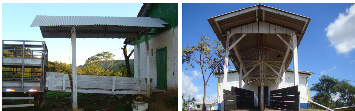
Figura 16. Embarcadouro com cobertura.
