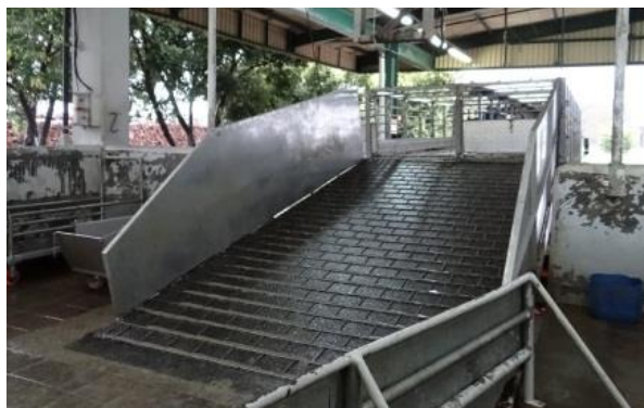
Figura 4. Rampa de desembarque para suínos no frigorífico com piso antiderrapante.
