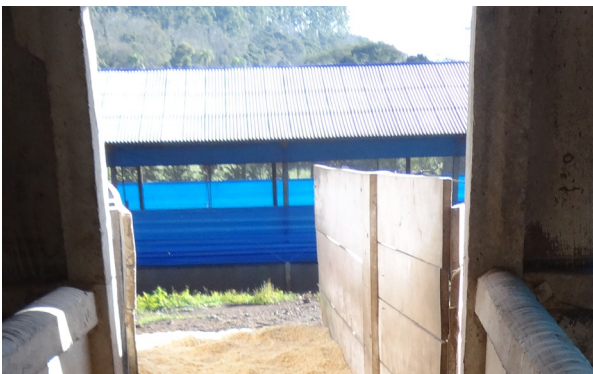
Figura 8. Embarcadouro com largura adequada.
