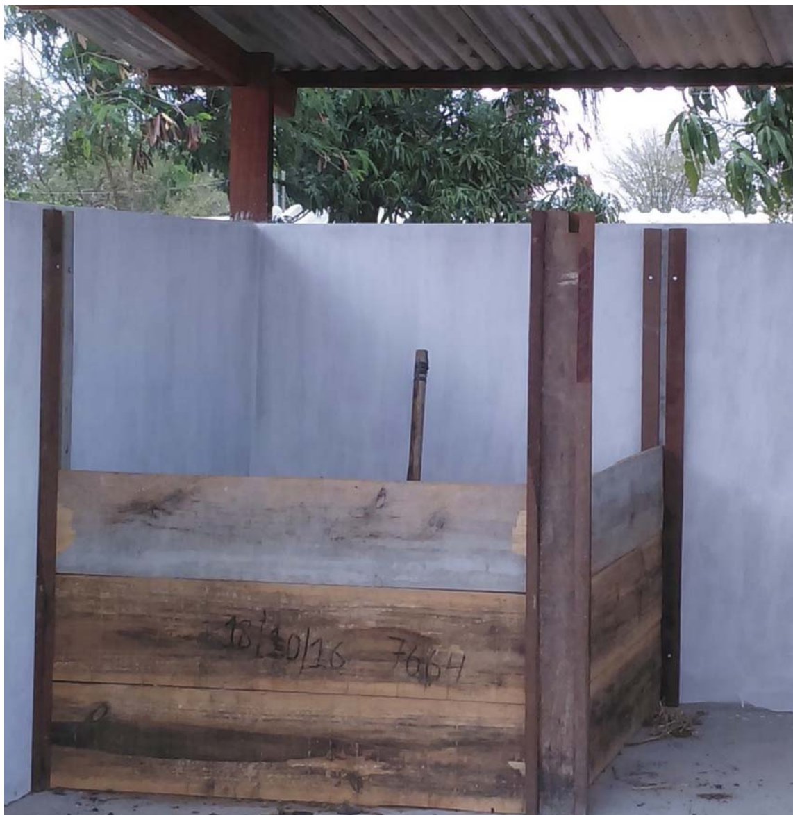
Figura 23. Composteira para animais mortos em local coberto e isolado, sem contato direto com o solo (Frei Paulo, SE, 2019).
