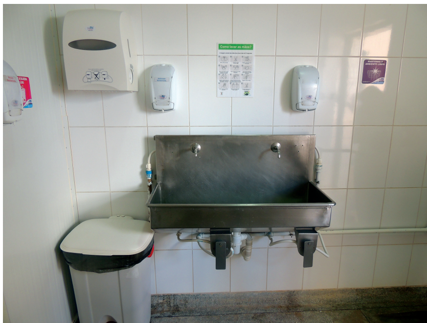
Figura 2. Revestimento de paredes para unidade de beneficiamento de pescado (UBP) em porcelanato e modelos de lavatórios com anexos para higienização na entrada.
