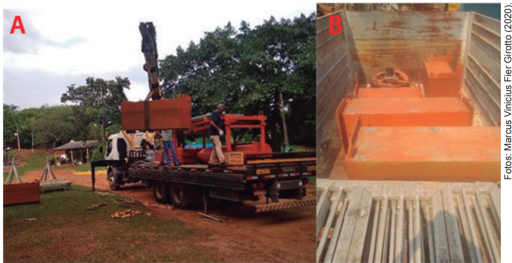
Figura 10. Caminhão munck utilizado para retirada das peças da caçamba (A), e caminhão de carga seca utilizado apenas para transporte das peças da plataforma (B).
