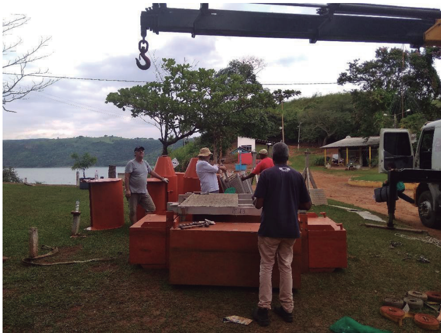
Figura 19. Flutuadores e assoalho da Plataforma de Coleta de Dados já fixados.
