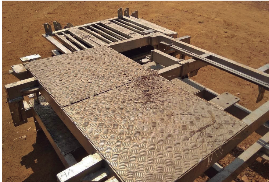
Figura 17. Assoalho da plataforma (primeiro plano) e laterais da plataforma (segundo plano).
