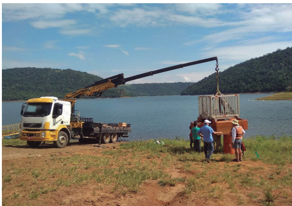
Figura 22. Plataforma de Coleta de Dados içada para fixação da haste de sustentação da poita.
