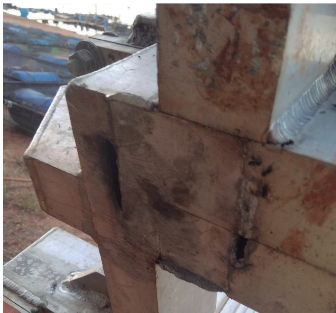
Figura 41. Solda do assoalho que fixa o flutuador foi rompida.
