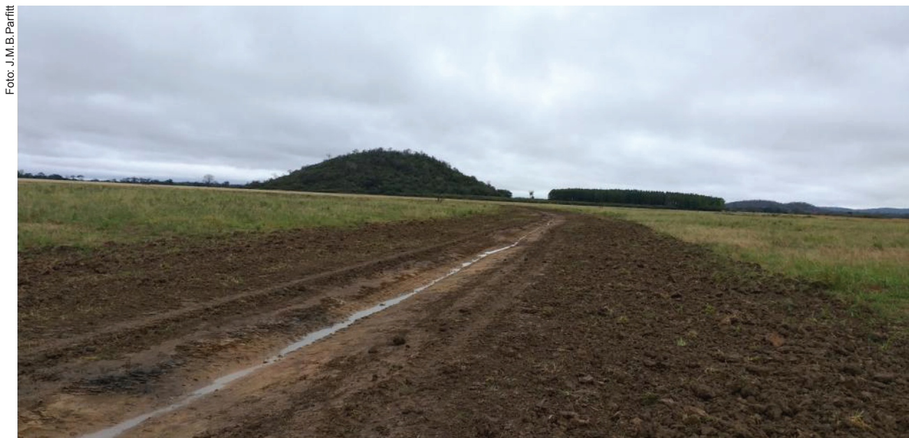
Figura 11. Dreno em área de terra baixa executado com patrola, permitindo o trânsito de máquinas em seu interior.
