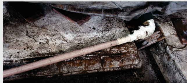
Figura 2. Vala embaixo do tanque de lona para passagem dos canos.
