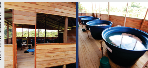
Figura 3. Imagem externa e interna do galpão suspenso instalado em local com alagamentos.
