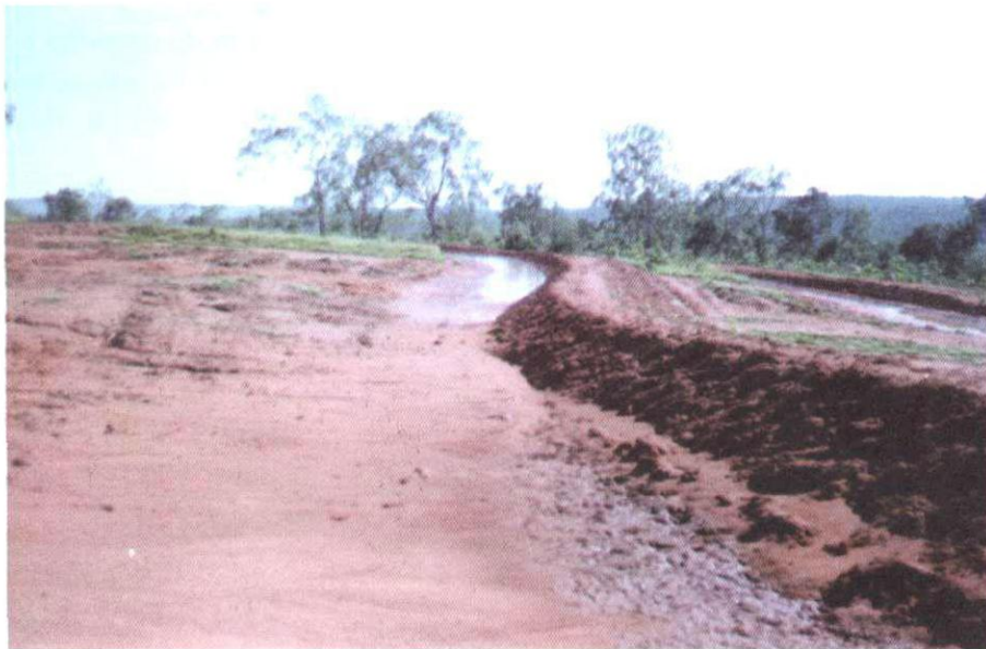
Figura 10. Sistema de terraço invertido para controlar a erosão em área de ocorrência de Areia Quartzosa latossólica no município de Alcinópolis-MS.
