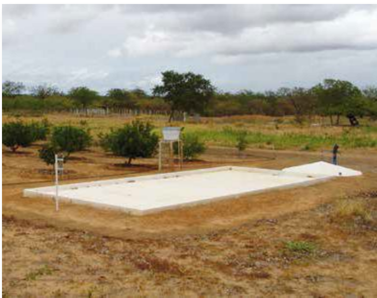
Figura 3. Sistema de captação da água de chuva por meio do Programa Uma Terra e Duas Águas (P1+2).
