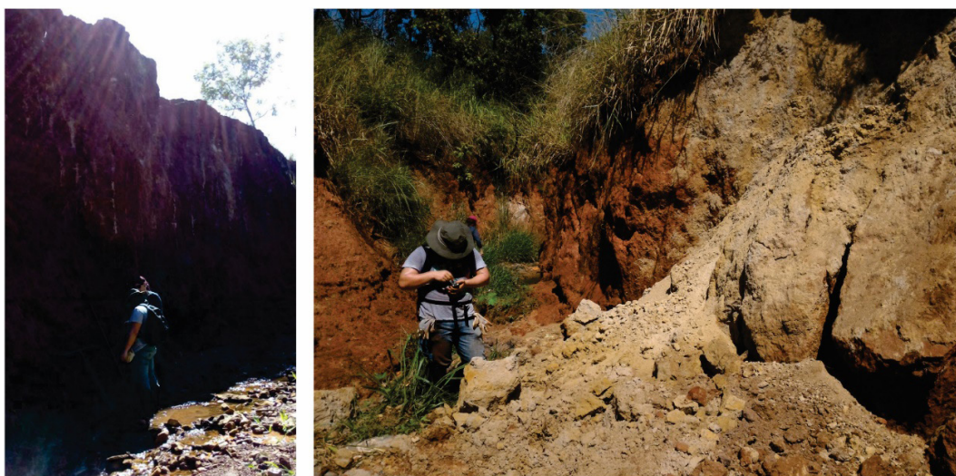
Figura 5 - Talude declivoso da voçoroca (esquerda) e massa de terra deslizada (direita) evidenciado a que os processos erosivos estão ativos
