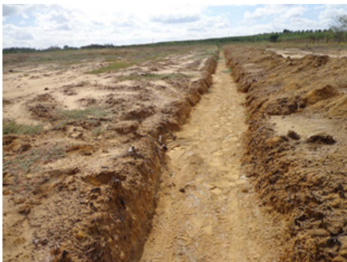
Figura 4. Dreno localizado no limite ao norte da Área 1, mostrando a presença de afloramento de sais. Foto: Sílvio Tavares.
