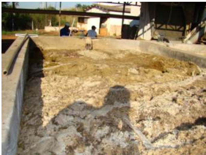
Figura 3. Tanque de flotação evidenciando acúmulo de material sólido flotante proveniente da linha verde de frigorífico de abate de bovinos.
