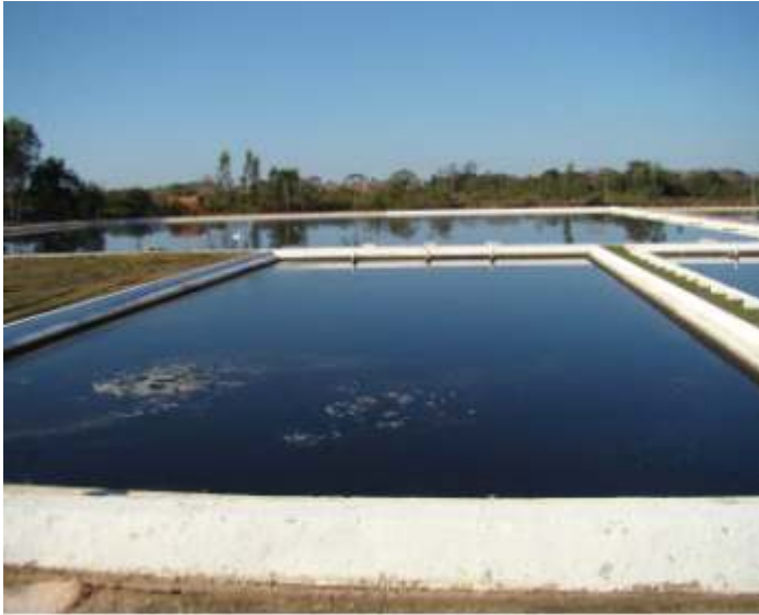
Figura 4. Associação de lagoas aeróbicas e anaeróbicas para depuração dos resíduos líquidos gerados em frigoríficos.
