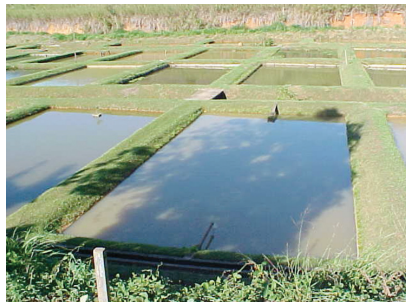
Figura 19. Talude de viveiros protegido com grama-batatais para evitar erosão. Foto: Fabrício P. Rezende.
