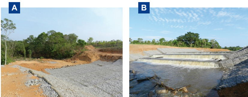
Figura 16. Detalhe do vertedouro em barragem de grande porte: vista em período de estiagem (A); vista à montante no período das chuvas (B). Fotos: (A) Guilherme Yoshizawa; (B) Cátia A. Veiverberg.
