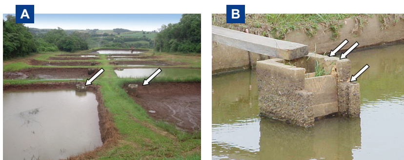
Figura 17. Bateria de viveiros, mostrando sistema de escoamento total da água por monges (setas) (A); Detalhe de monge com três frisos possibilitando o controle e escoamento e renovação de água (B). Fotos: (A) Giovani T. Bergamin; (B) Fabrício P. Rezende.
