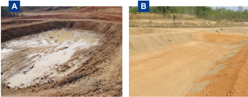
Figura 18. Viveiro com fundo lamacento (A) e viveiro com camada de cascalho compactado (B). Fotos: (A) Fabrício P. Rezende; (B) Giovani T. Bergamin.
