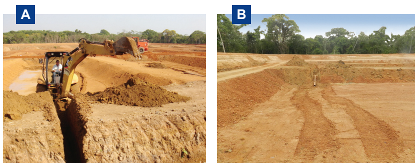
Figura 13. Corte para instalação da tubulação de escoamento (A) e alocação do tubo na cota mais baixa do viveiro (B). Fotos: (A) Fabrício P. Rezende; (B) Giovani T. Bergamin.
