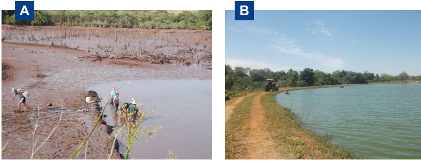
Figura 7. Açude em que a vegetação não foi retirada, impossibilitando despesas parciais (A); Viveiro corretamente construído, com imagem de despesa parcial (B). Fotos: (A) Cátia A. Veiverberg; (B) Marcela Mataveli.
