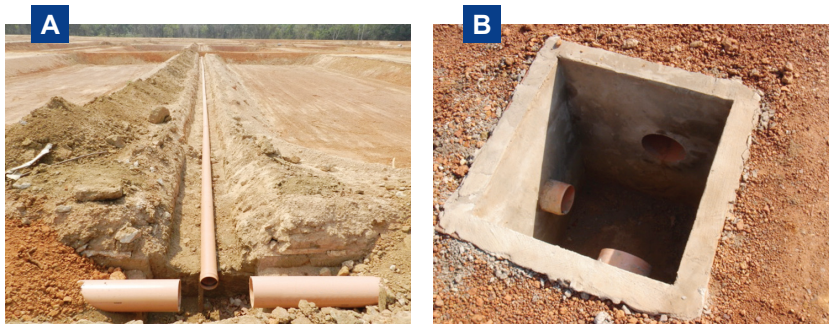
Figura 12. Sistema de abastecimento de água por tubulação de PVC Ocre (A); Caixas de inspeção e distribuição de água (B). Fotos: (A) Giovani T. Bergamin; (B) Fabrício P. Rezende.
