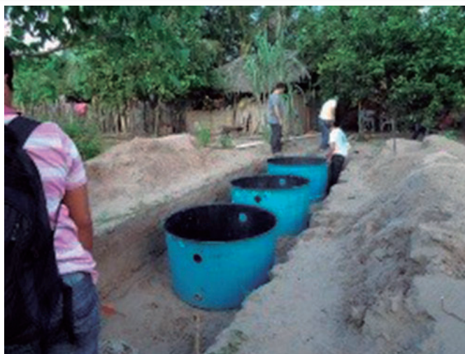
Instalação de Unidade de Aprendizagem em Saneamento Rural - Fossas Sépticas (Foto: Embrapa Cocais)
