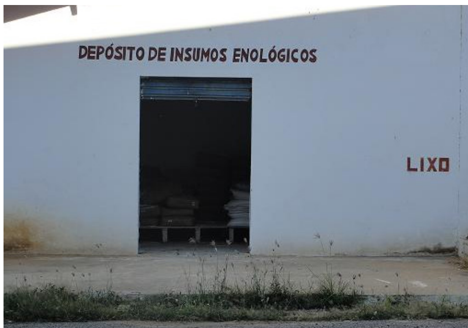
Figura 10. Esta figura exemplifica o depósito para armazenagem dos insumos enológicos fechado e isolado da vinícola, nota-se que os insumos encontram-se em pallets distantes do chão a uma altura de mais de 45 centímetros conforme indicado pelas regras de Boas Práticas de Fabricação.
