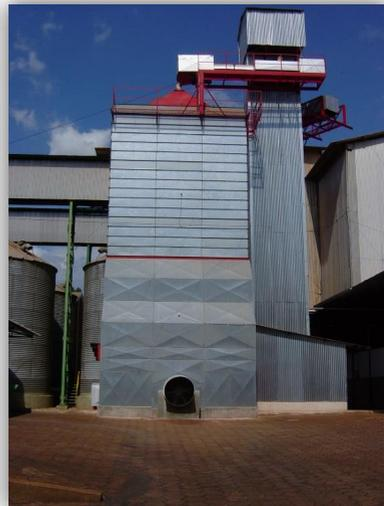
**Figura 32.** Silo secador estático com secagem radial, à esquerda, e secador intermitente para semente, à direita.
