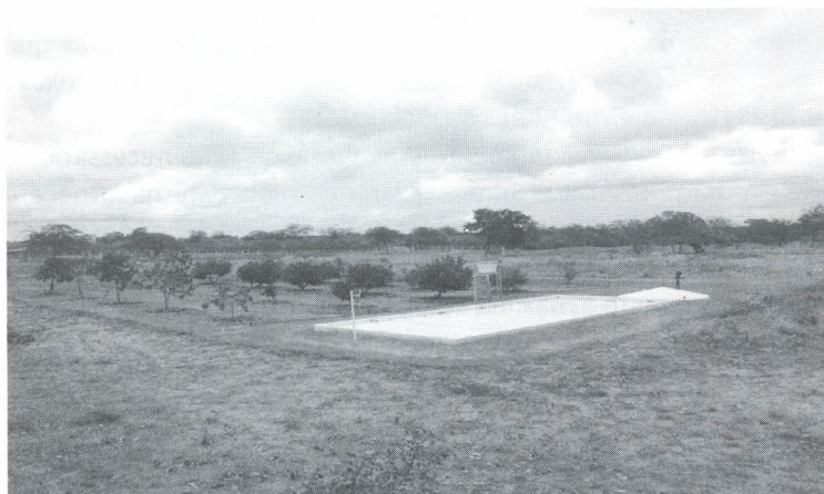
Figura 3. Cisterna de produção instalada em área experimental da Embrapa Semiárido Foto: Nilton de Brito Cavalcanti
