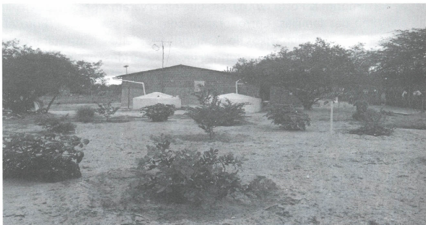
Figura 2. Cisternas de consumo humano e de produção, instaladas na Comunidade de Lage Alta, município de Jaguarari, BA. Foto: Nilton de Brito Cavalcanti
