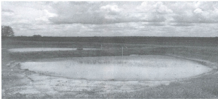
Figura 22. Barreiro para uso em irrigação de salvação de culturais anuais Foto: Nilton de Brito Cavalcanti
