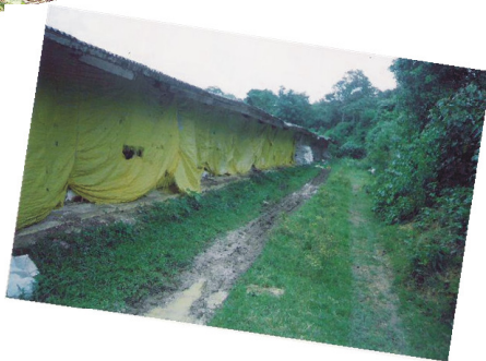
Presença de mato alto próximo as instalações
