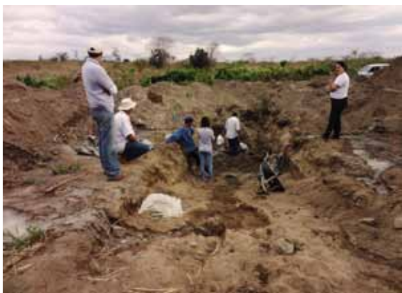
Participantes de Dia de Campo sobre construção de barragem subterrânea, em Buíque, PE, em 2013.
